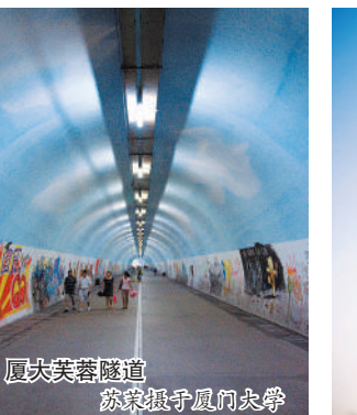
厦大芙蓉隧道
